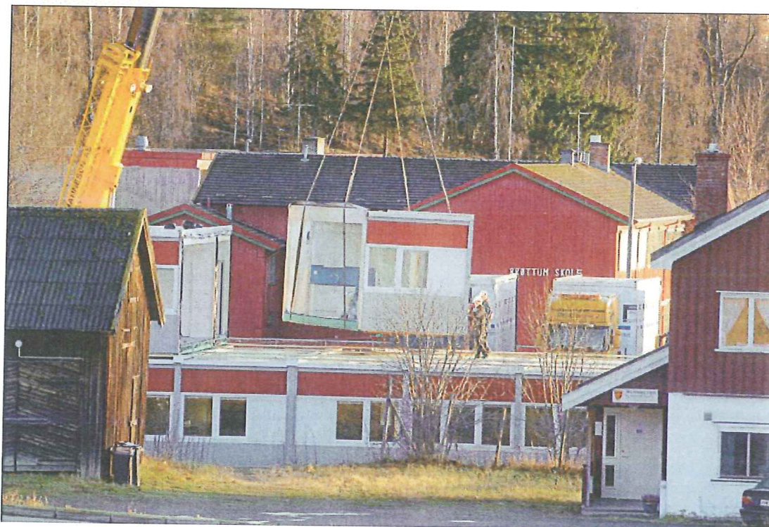
Brakkeriggen som skal huse elever på Brøttum skole mens bygging av nyskolen pågår er levert. Men Ringsaker kommune har avlyst anbudsrunder for å bygging av nyskolen og hele prosjektet er nå kastet ut i stor usikkerhet med tanke på kostnadsramme og byggestart. Foto: Ole Johan Storsve
